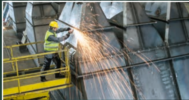
Gemaakt voor echt zware werkzaamheden: de Metabo haakse slijper met Marathon-motor bij permanent gebruik bij de containerbouw.
